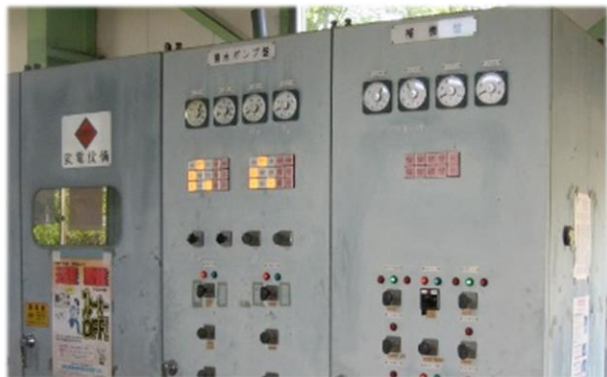
電気設備更新
