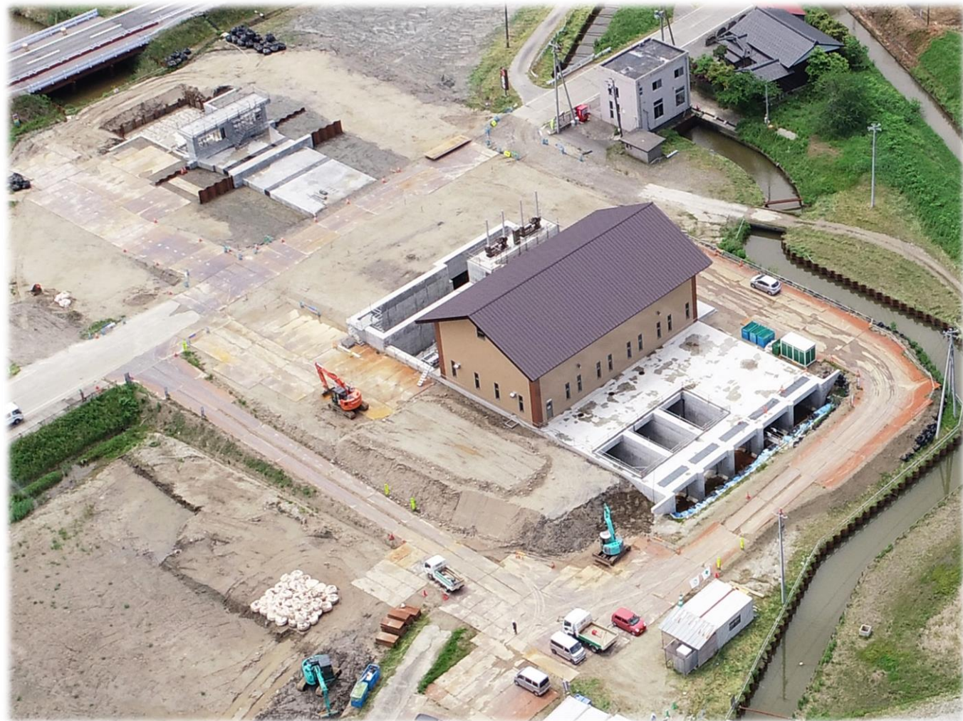
<建設中の万十郎川排水機場>
